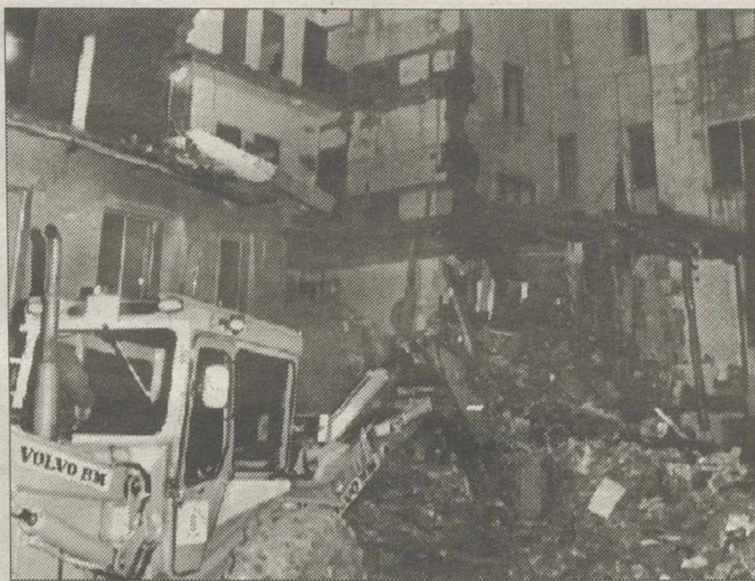
El desplome comenzó en el tejado y arrastró a todos los pisos inferiores.
