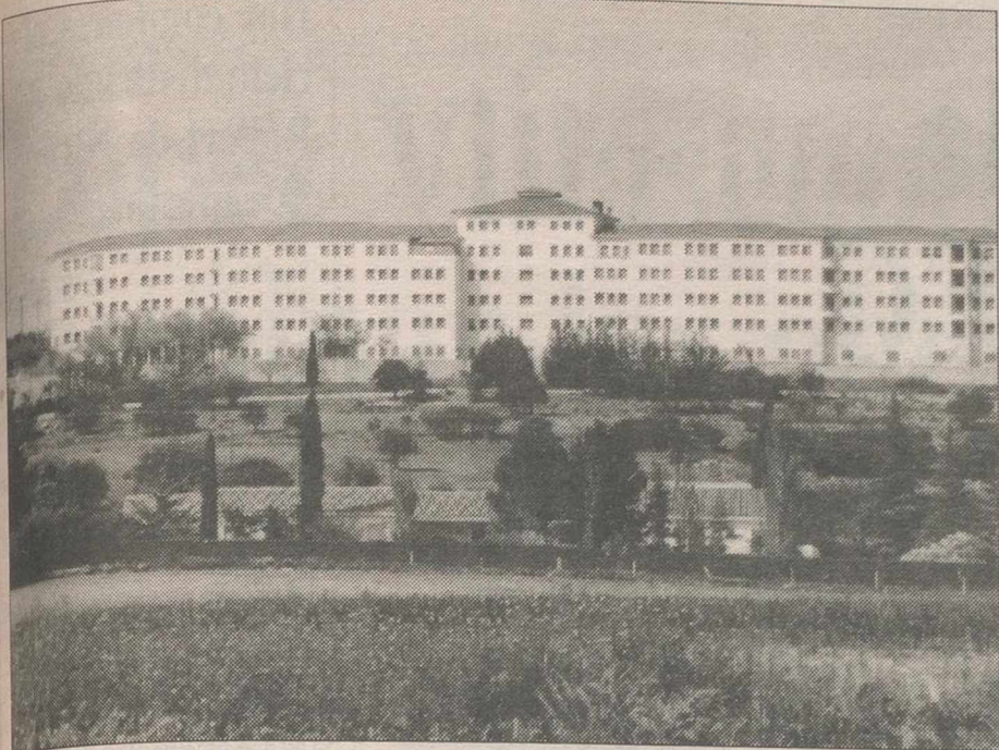
El PP quiere que el edificio de la Atalaya sea derruido.
