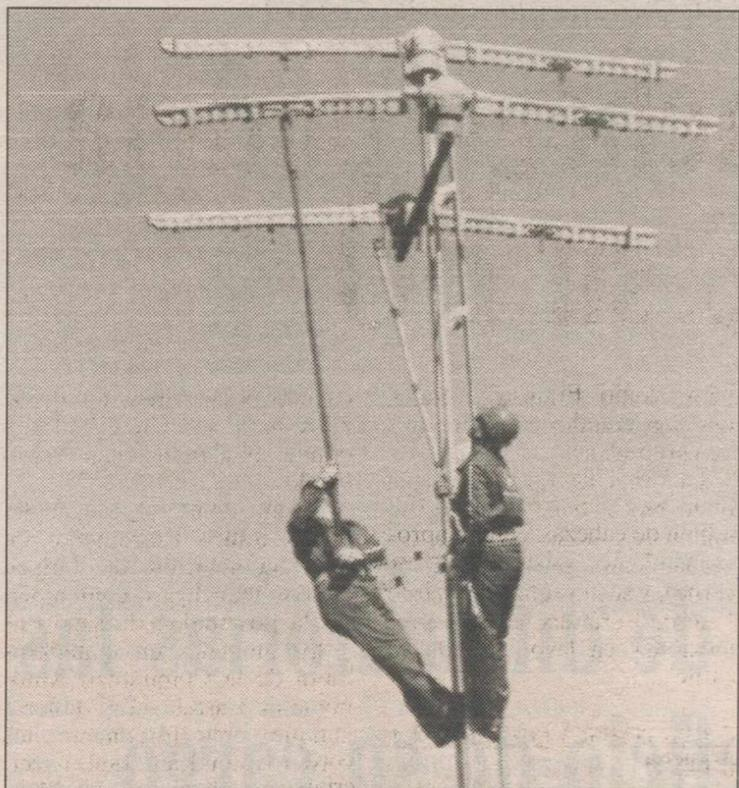
Los obreros de Unión Fenosa instalan las protecciones en la línea de alta tensión.
