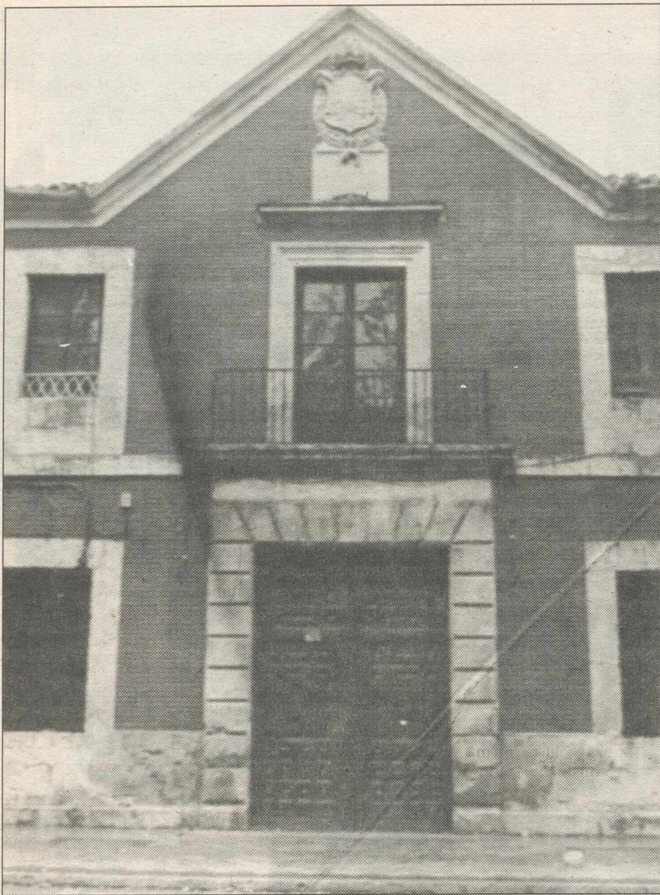
Fachada del antiguo Cuartel de Artillería, en la calle Altgracia.
