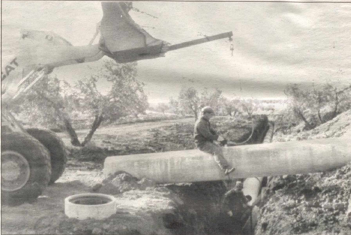
Las obras del trasvase Torre-Gasset van a buen ritmo
