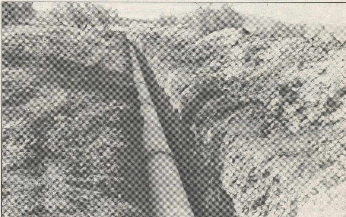
Las obras se prolongan a lo largo de veinte kilómetros
