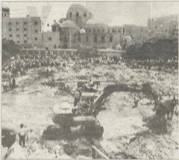
Máquinas excavadoras trabajan en las labores de desescombro.
