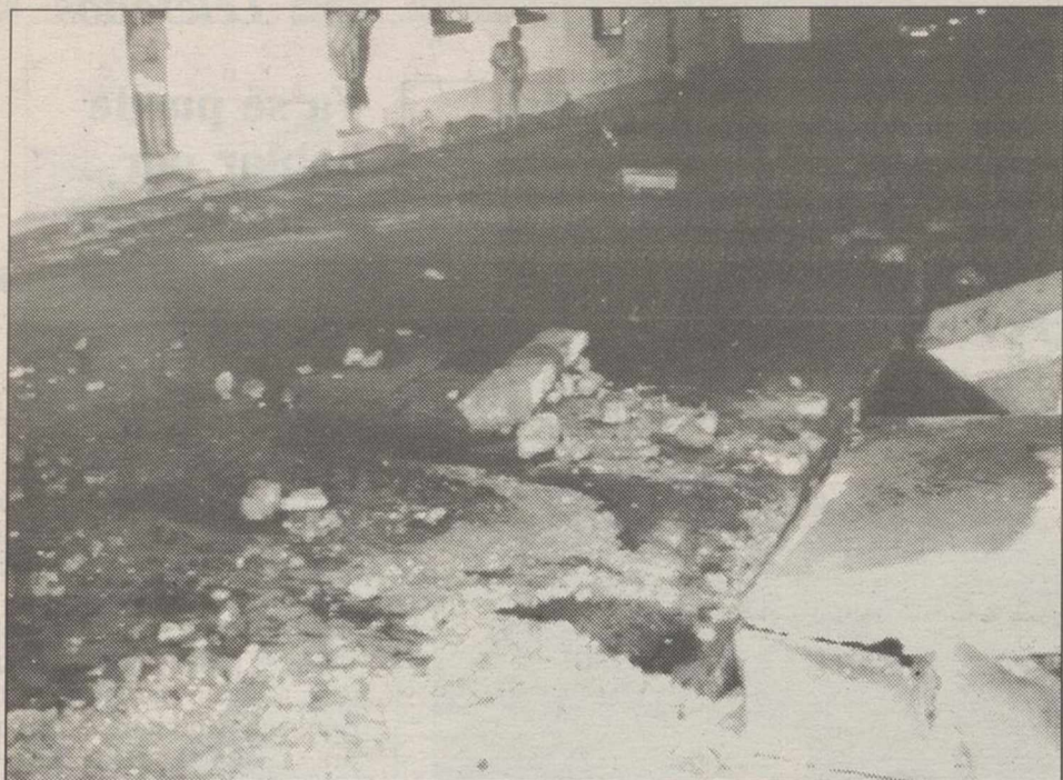
En la imagen puede apreciarse considerables destrozos materiales.
