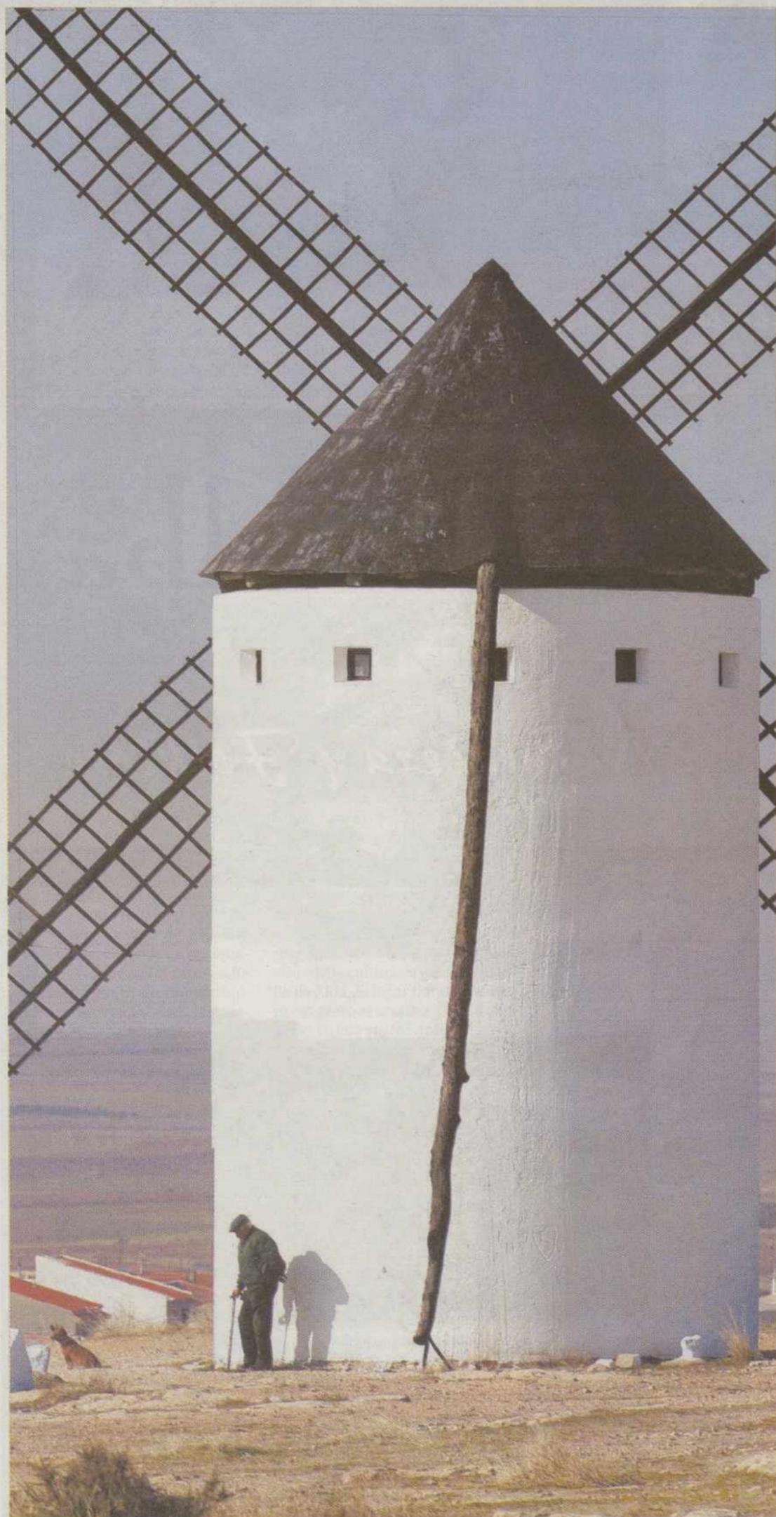
El madero que sale del techo del molino hasta el suelo es el 'palo de gobierno' que permite girar la parte superior del molino. / T.F.
