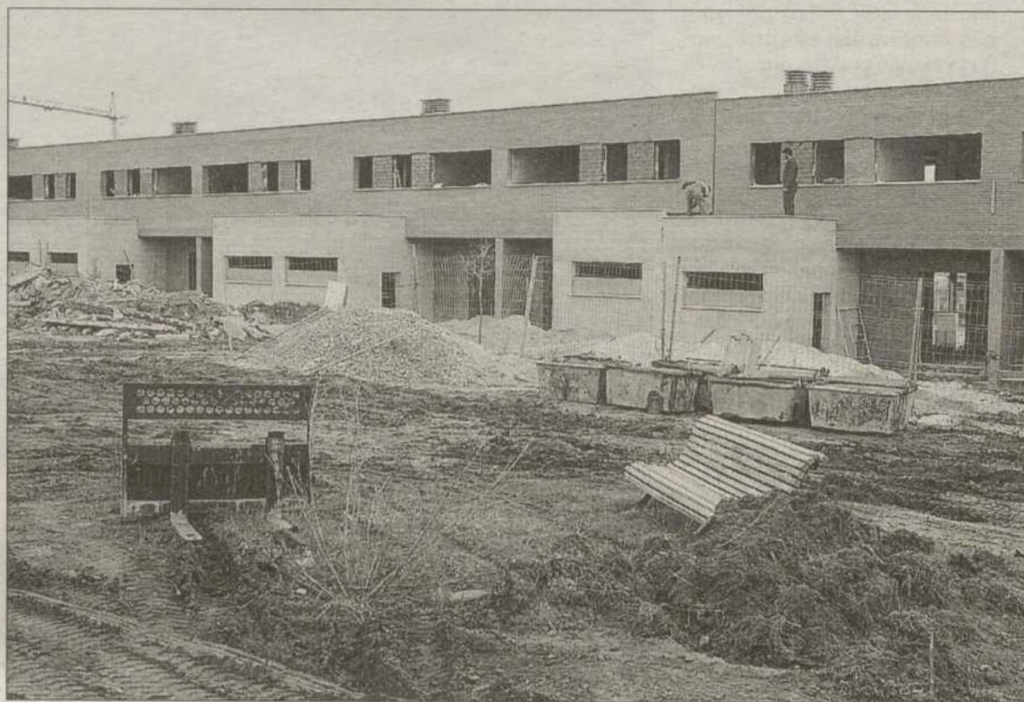
Los trabajadores de la construcción seguirán mejorando sus condiciones de seguridad en el trabajo. / DAVID PÉREZ
