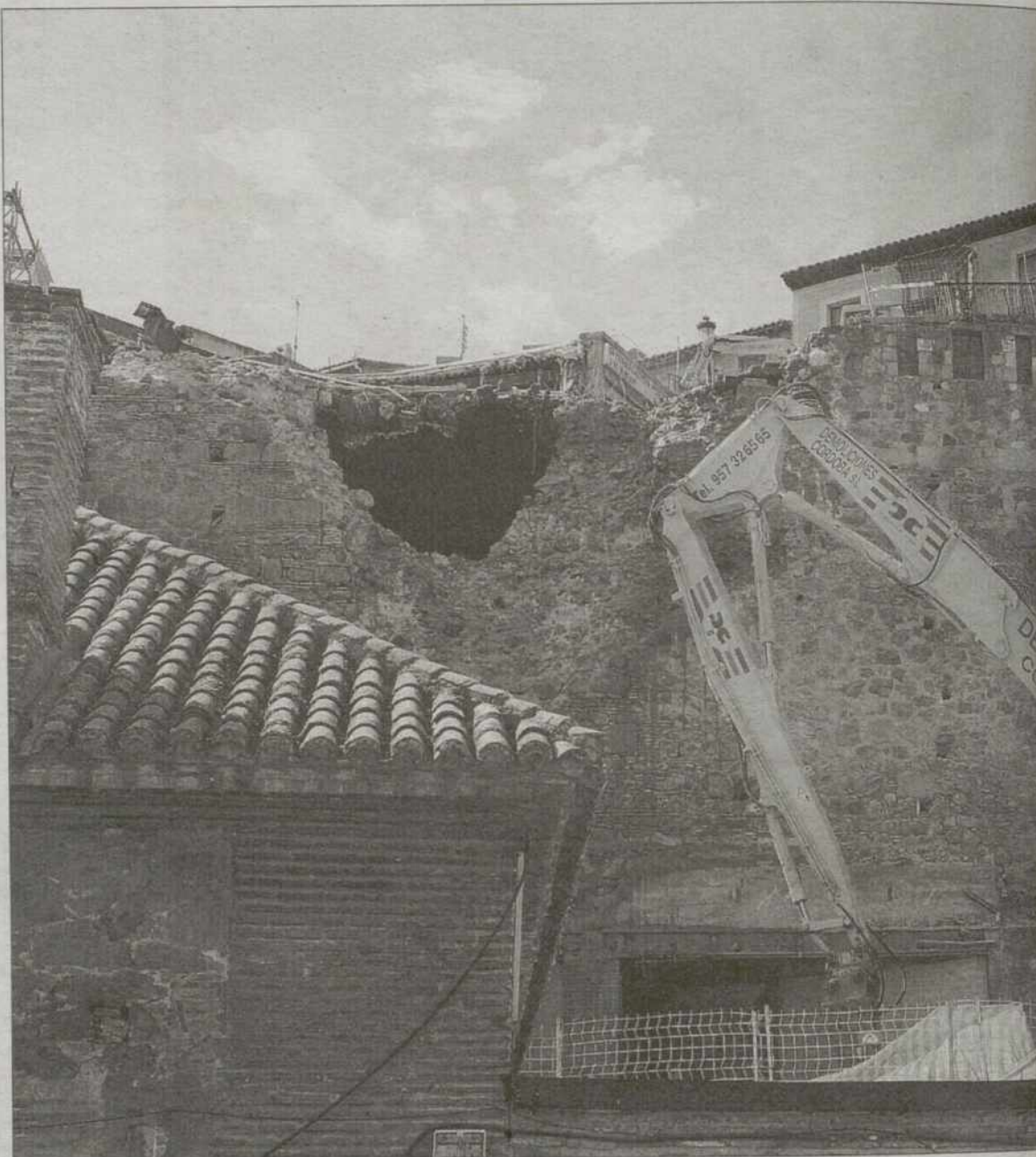
Desde que comenzaron las demoliciones, los trabajadores de Gerardo Lobo están en «peligro». / DAVID PÉREZ
