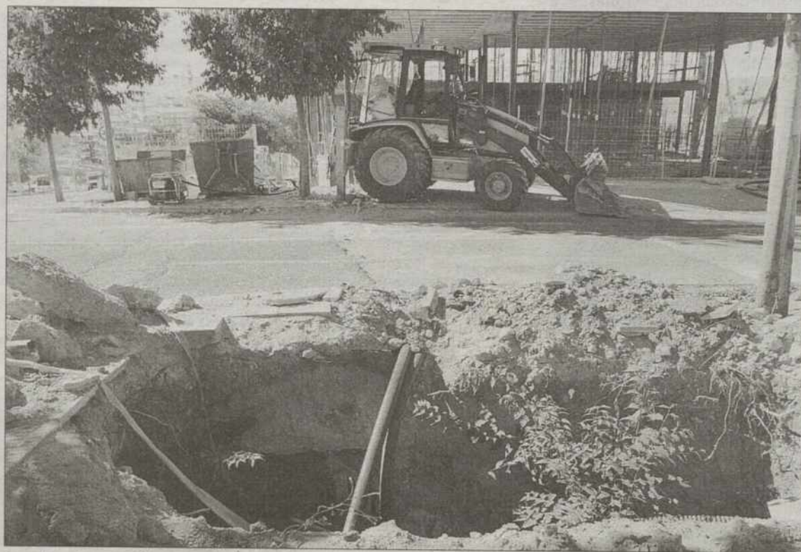
Las obras de reparación comenzaron el pasado miércoles. / VALDIVIELSO
