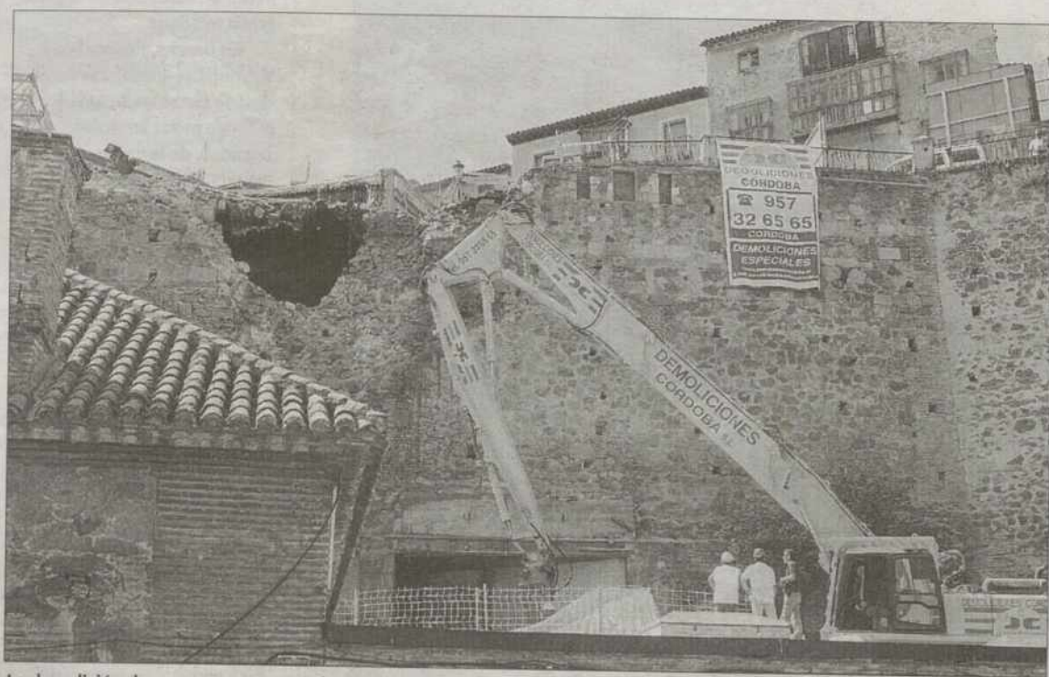
La demolición de un muro parece ser la causa de los fuertes ruidos y vibraciones. / DAVID PÉREZ
