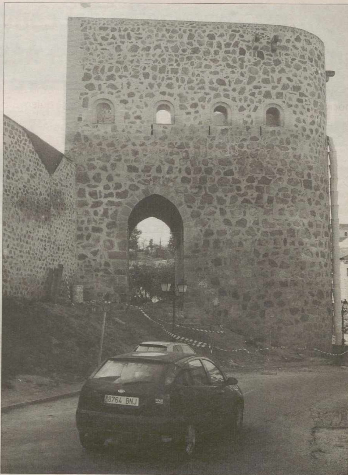
Patrimonio debe dar su permiso para que concluyan las obras./DAVID PÉREZ
