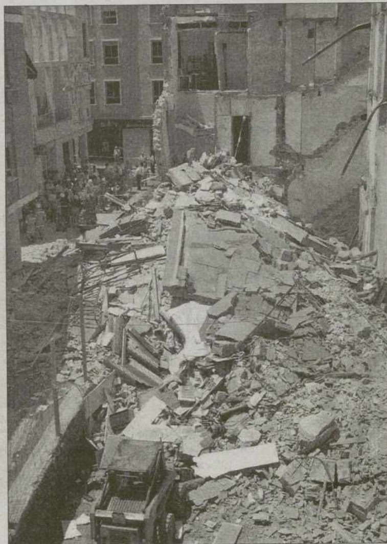
Estado en el que quedó el edificio de Alcira tras derrumbarse. / J.C.C. (EFE)
