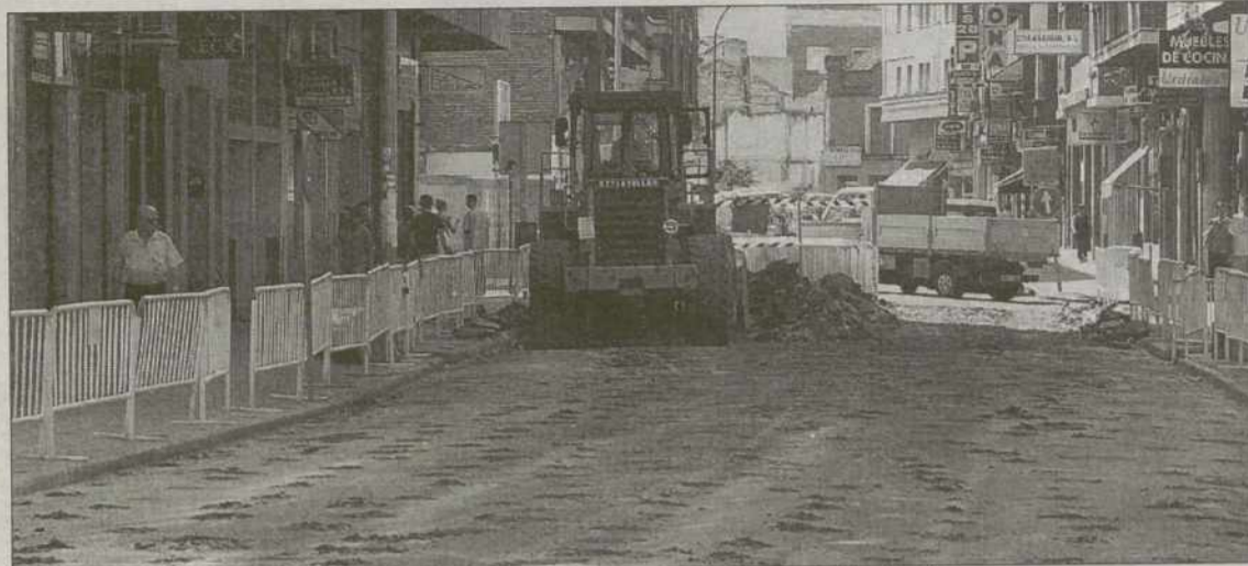
La pala excavadora realizaba los primeros trabajos taladrando ayer el pavimento de la calle Alfares. / MANU REINO
