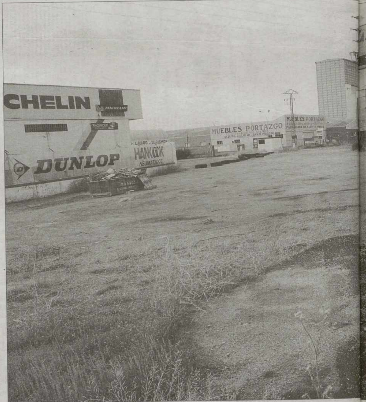
Las obras de la Tercera Fase PERI I, en el Polígono Industrial, concluirán en julio de 2003. EVA GARRIDO
