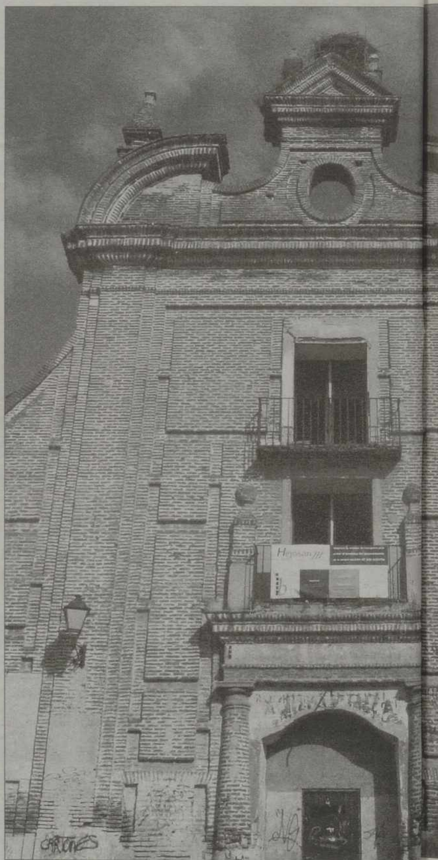
Las obras de recuperación se prolongarán por espacio de un año. / M. REINO
