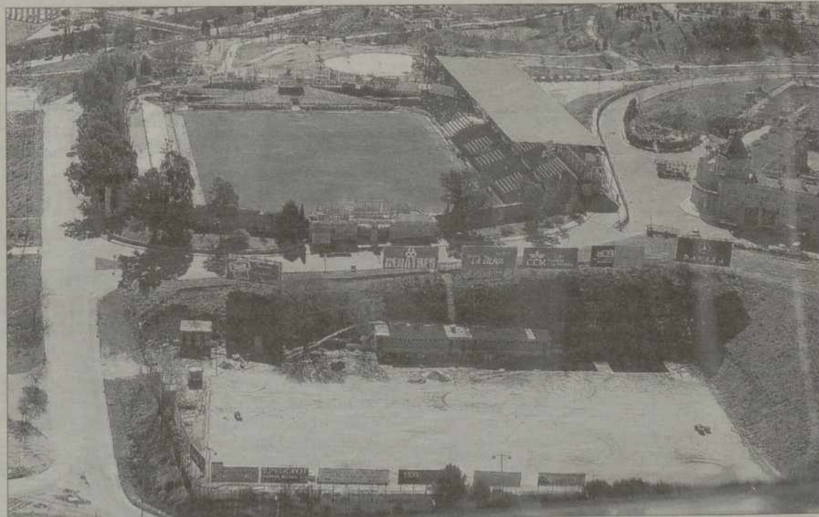
Vista aérea de las instalaciones del Salto del Caballo. / DAVID PÉREZ
