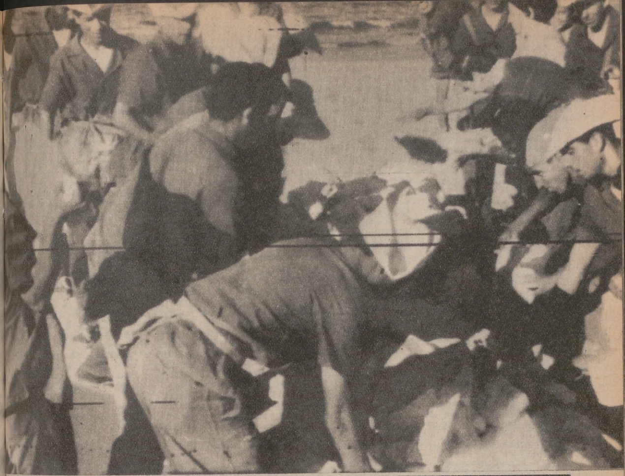
Horas antes de que diera comienzo la lucha, los voluntarios de la Guardia Nacional tunecina erigen una barricada sobre una carretera próxima a la base
