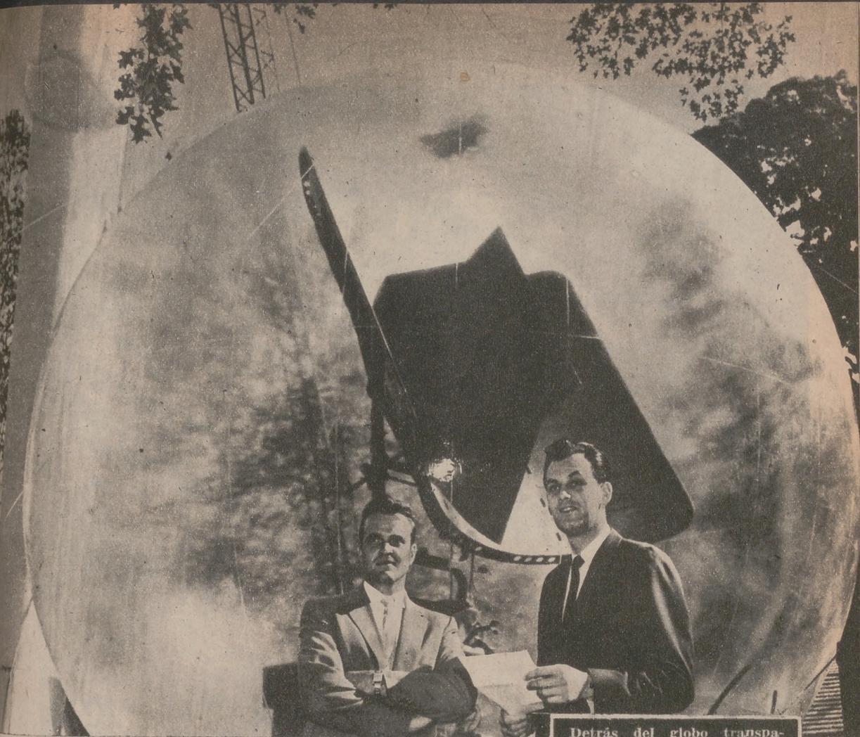
Detrás del globo transparente está la antena de un radar que permite determinar la situación y velocidad de aviones supersónicos y proyectiles dirigidos
