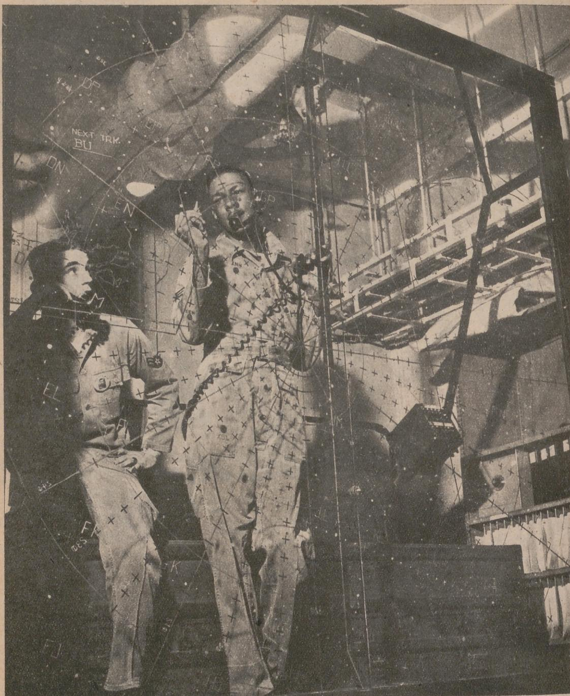
Sobre el vidrio se anotan los datos del radar
