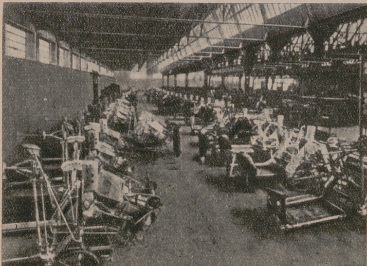
Montaje en serie de máquinas segadoras atadoras en la fábrica de materiales agrícolas de Vitoria. La industria española progresa en la técnica industrial de explotaciones para el campo
