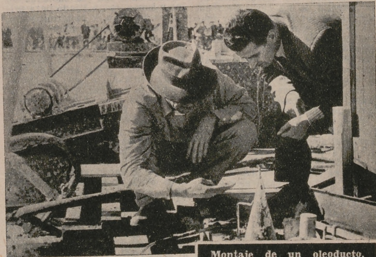
Montaje de un oleoducto. Los técnicos trabajan sobre el terreno
