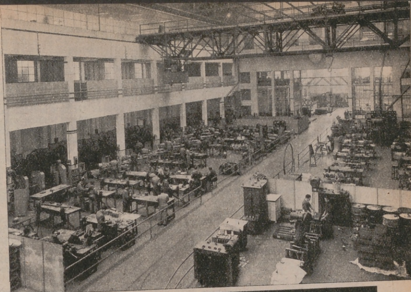
Vista de una nave de montaje de transformadores
