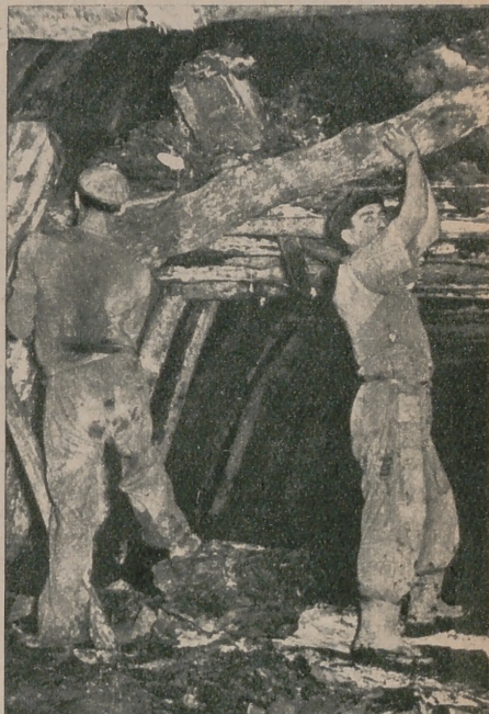
Picadores y entibadores realizan su delicado trabajo en el taller de la mina
