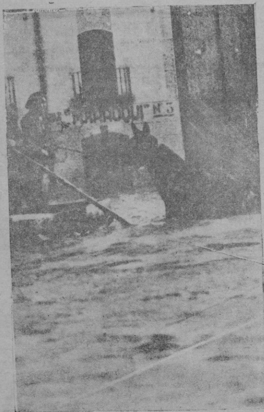
Las inundaciones en Salamanca. — Aspecto de una de las calles
