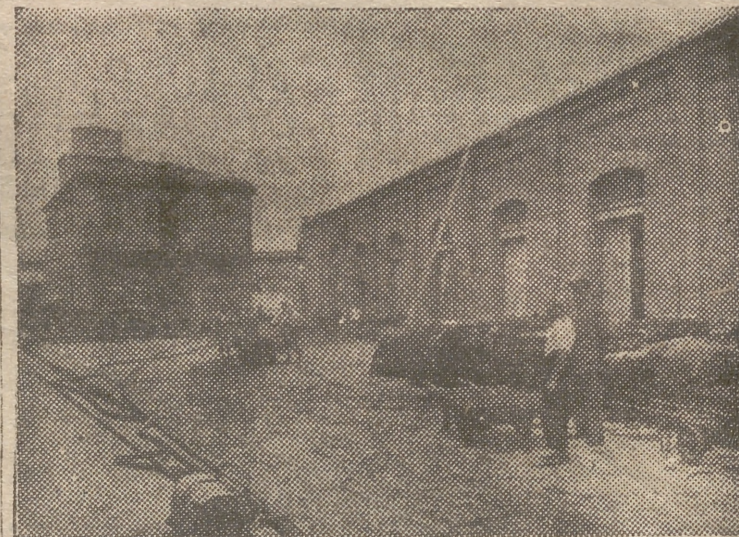
La entrada a la nave, durante los momentos del suceso. Al fondo, un coche del parque de bomberos. Una carretilla transporta materias ya apagadas, pero que podrían revivir el fuego.
