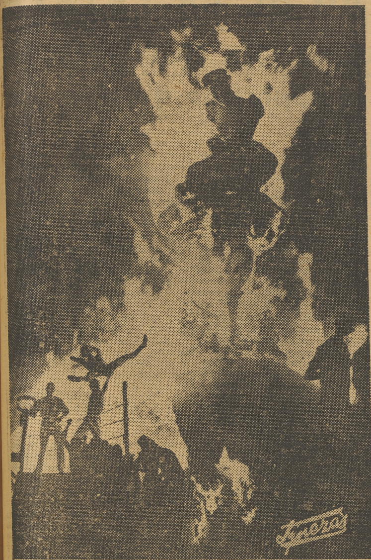
La "crema" de la falla del Mercado
