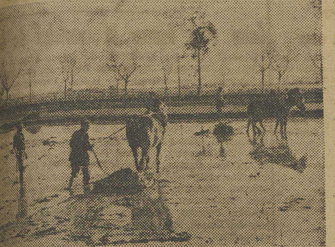
Nivelando las tierras de plantel
