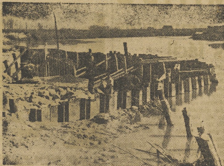
Barrera de tabicetas que protege las obras del Canal (Foto López-Egea)
