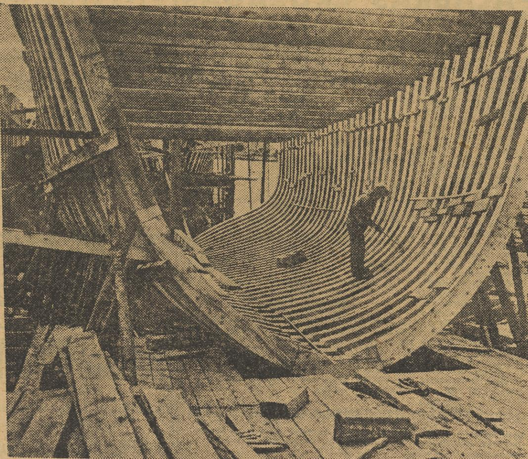
Trabajando en la estructura de un casco en construcción
