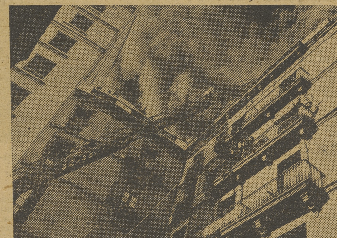
En Barcelona, un violento incendio, iniciado en un almacén de productos químicos de la plaza de las Beatas, ocasiona daños materiales de consideración. — (Foto Cifra)
