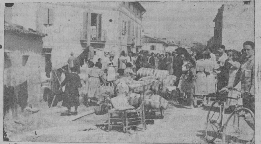
Un aspecto de la Ronda de Poniente.—Los muebles de las casas inundadas, en la calle. Fot. Ribas de Durán
