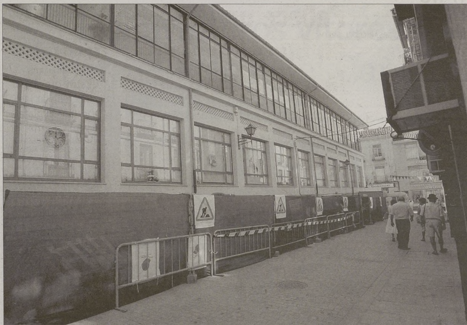
Las obras de la primera fase de la remodelación del entorno de la plaza de Abastos ya están terminadas. / DAVID CASTRO
