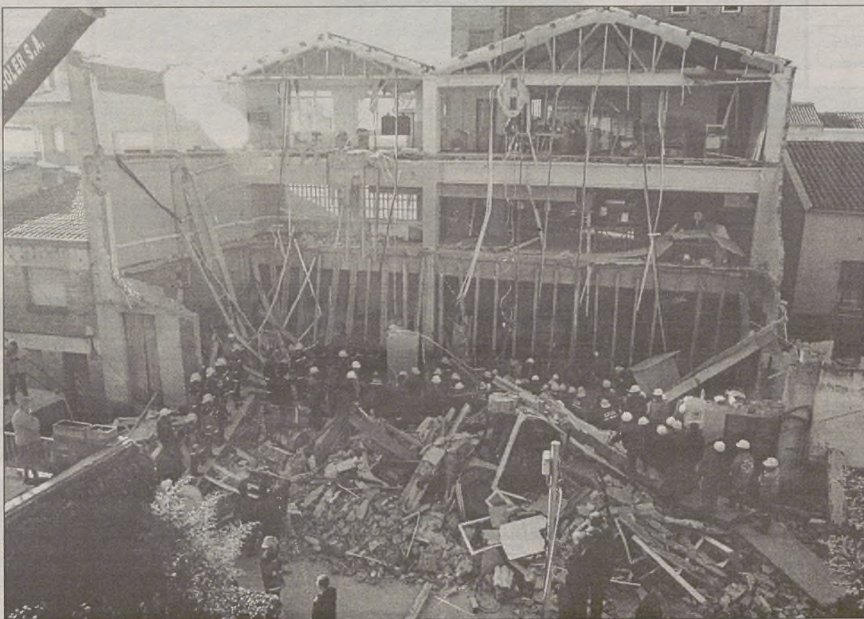
Los bomberos trabajaron entre los escombros en busca de víctimas.
