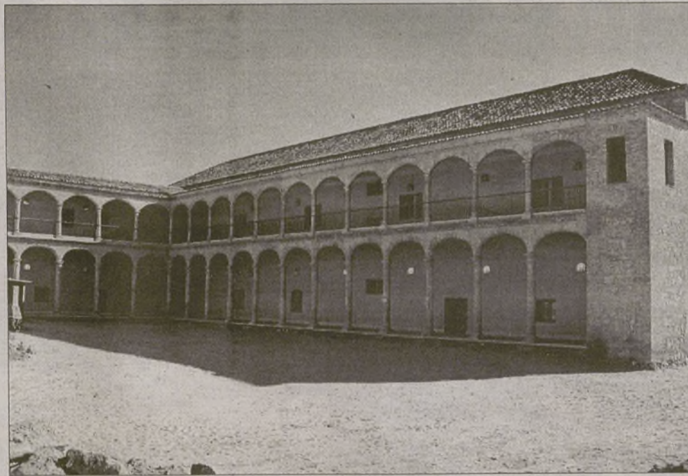
La restauración del Palacio de Don Pedro avanza a buen ritmo.
