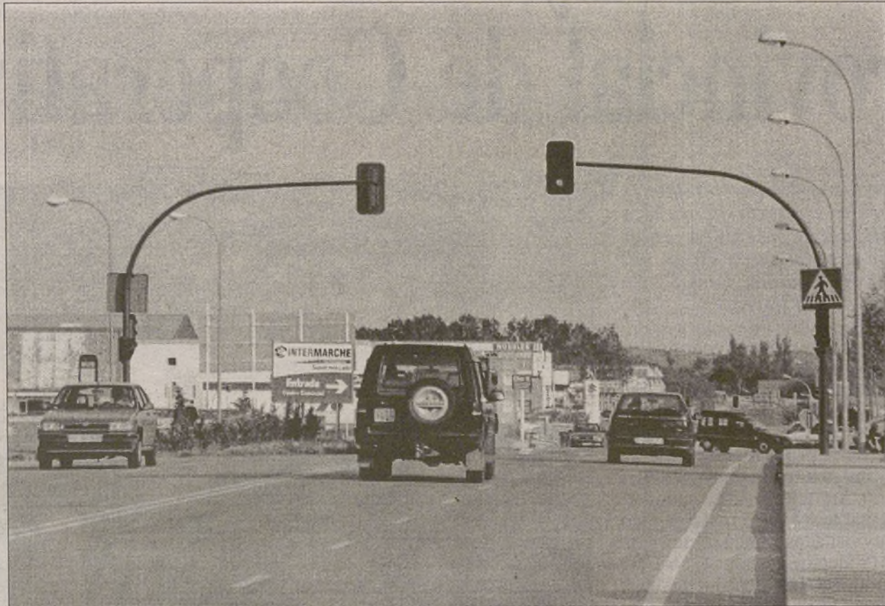
Una de las obras del Plan modificará el acceso a Cuenca por la carretera de Valencia.
