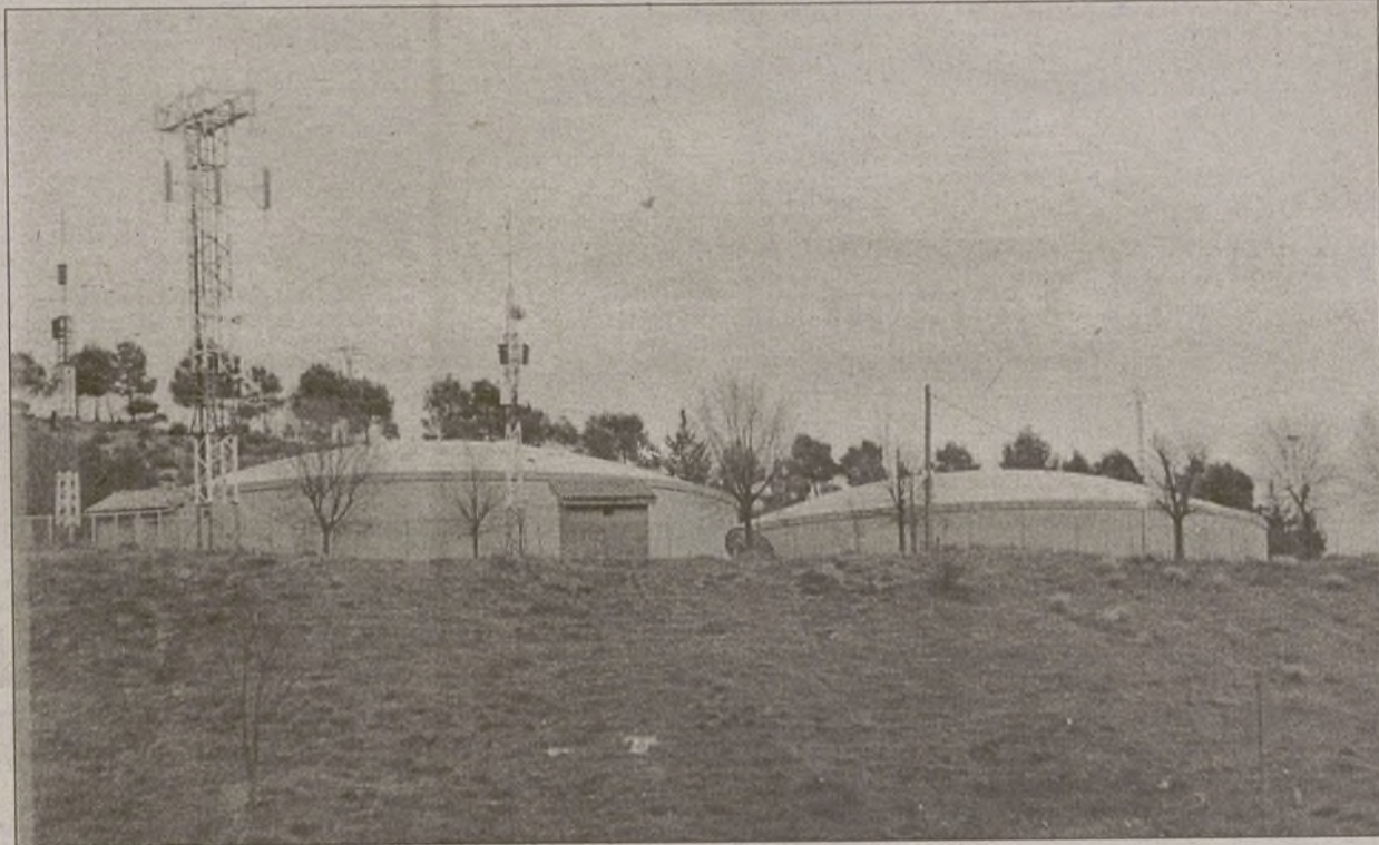
Depósitos de agua situados en la Subida de Santa Teresa.
