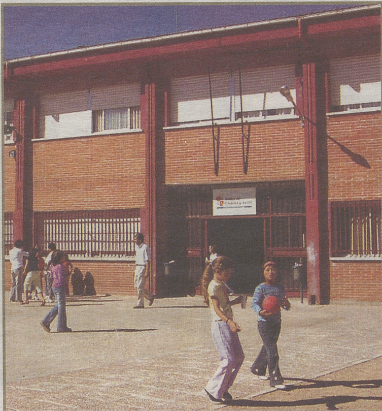
Fachada principal y patio del colegio Juan Luis Vives de Sotillo de la Adrada. / B. L.
