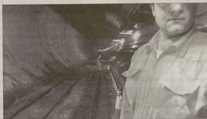
El tren de alta velocidad reforzará aún más sus medidas de seguridad. Prueba de ello es que, además de las galerías de interconexión, los túneles contarán con una sala de emergencia que tendrá una longitud de 500 metros, situada equidistante de las bocas. A ellas se accederá por galerías de conexión situadas cada 50 metros.
