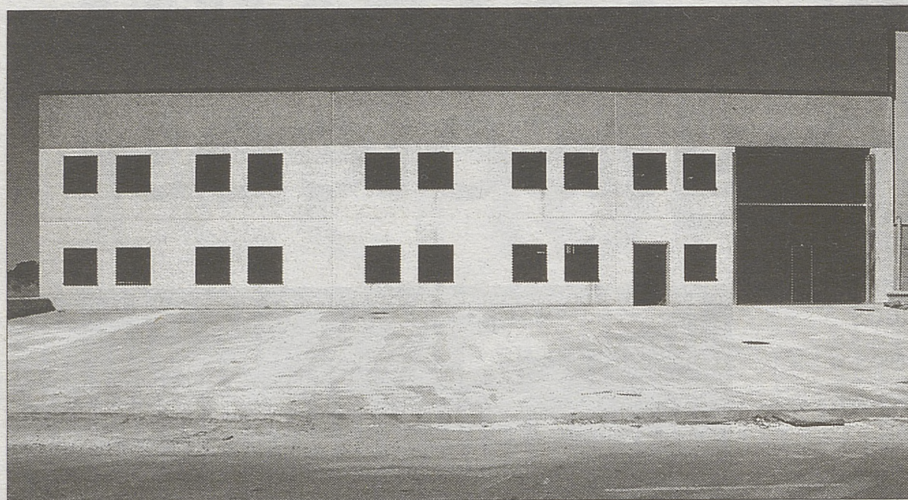
Naves en construcción, a la entrada del polígono.
