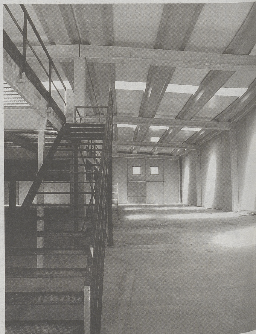
Interior de una de las naves en construcción.
