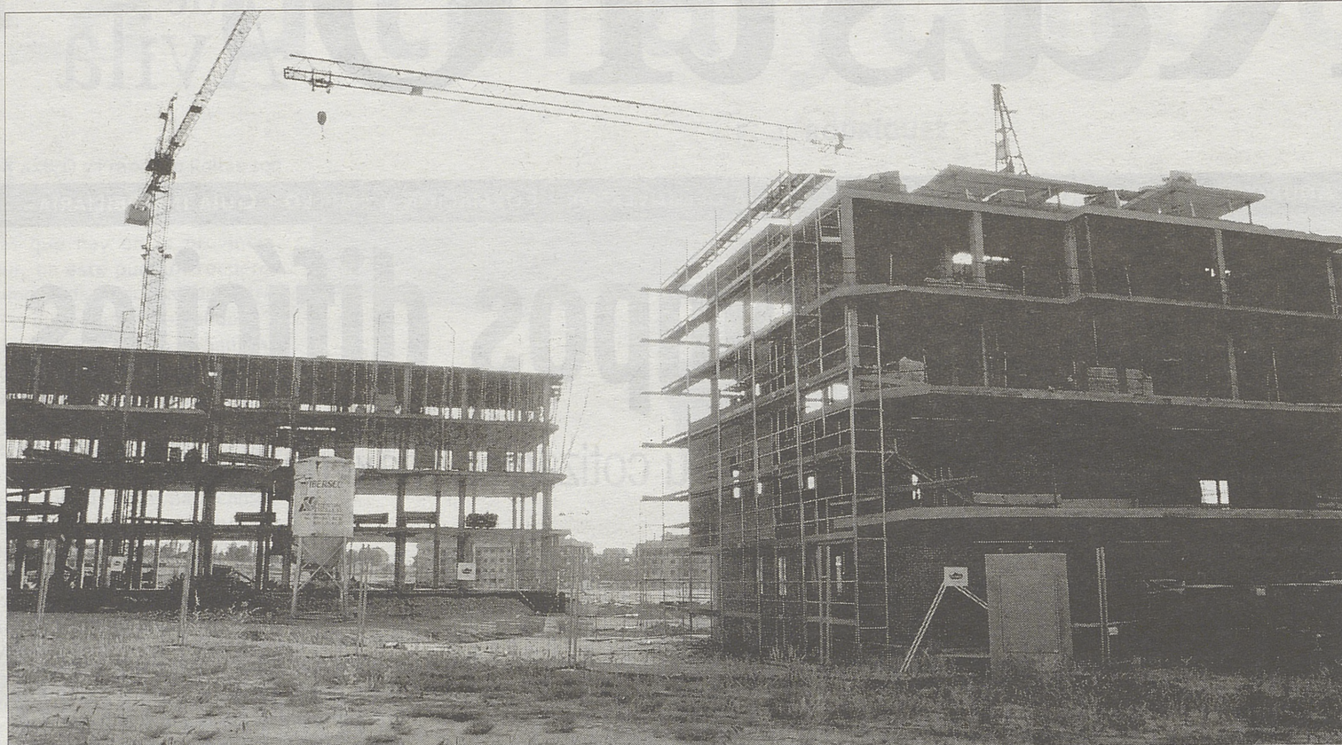
Viviendas en construcción en la Comunidad de Madrid.
