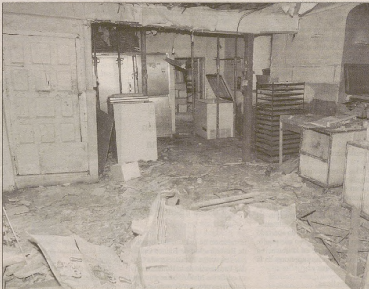
Aspecto de una vivienda abandonada en la calle Estrada / LUMBREAS
