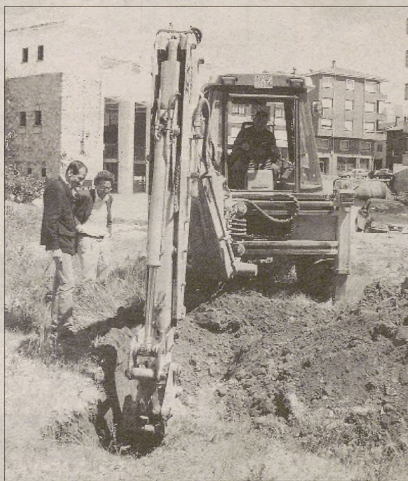
Imagen de la calicata realizada sobre los terrenos elegidos / LACABA
