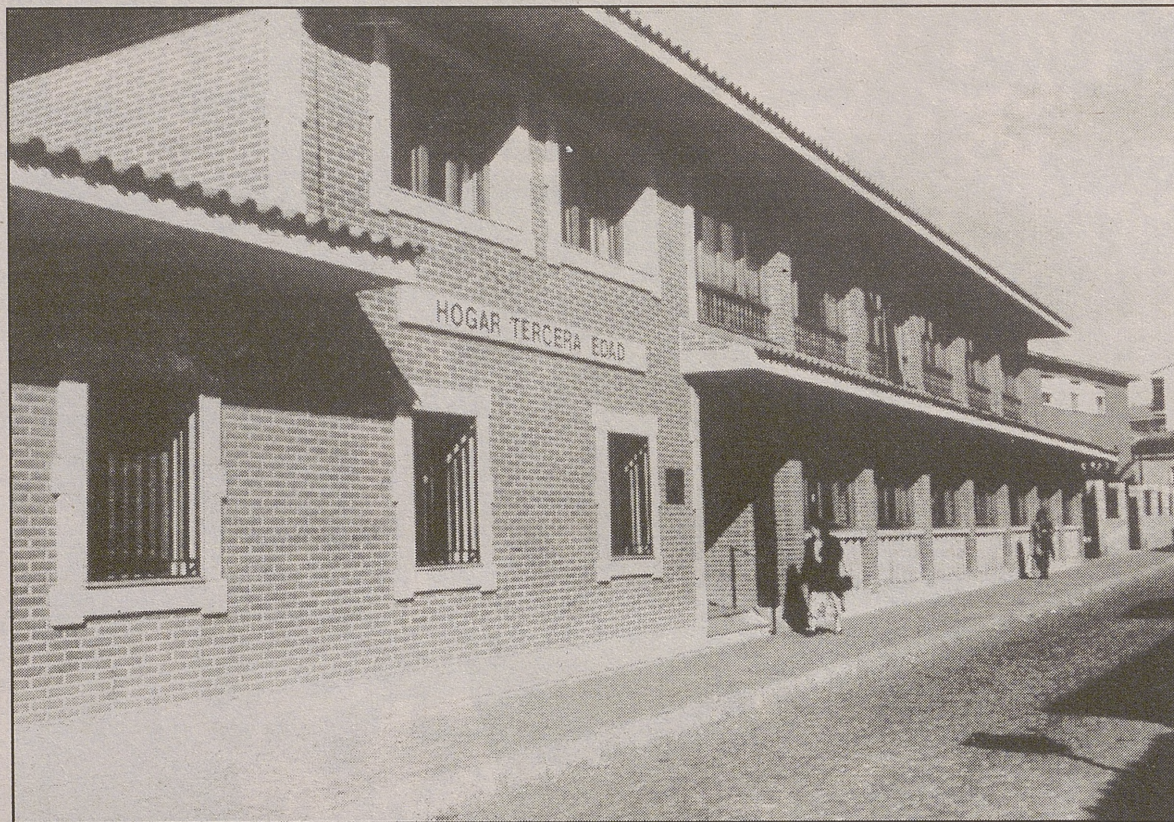
Fachada del Hogar que se encuentra en la calle Independencia.
