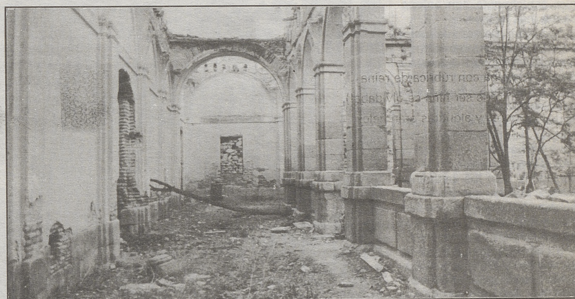
Estado actual del interior del convento.
