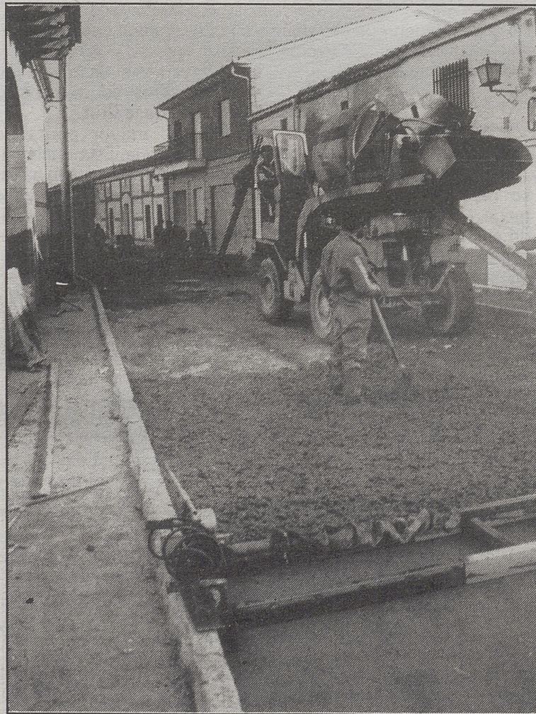
La calle del Santo, arreglada con motivo del Centenario
