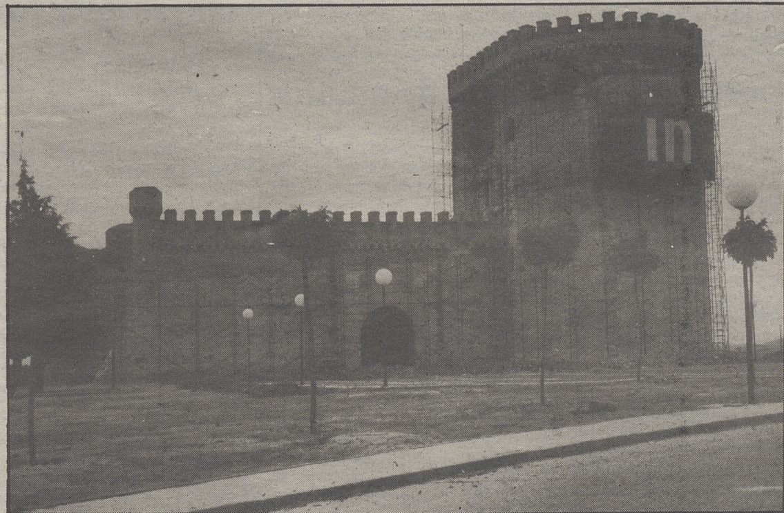
El Castillo de Arévalo presenta estos días el aspecto que muestra la fotografía
