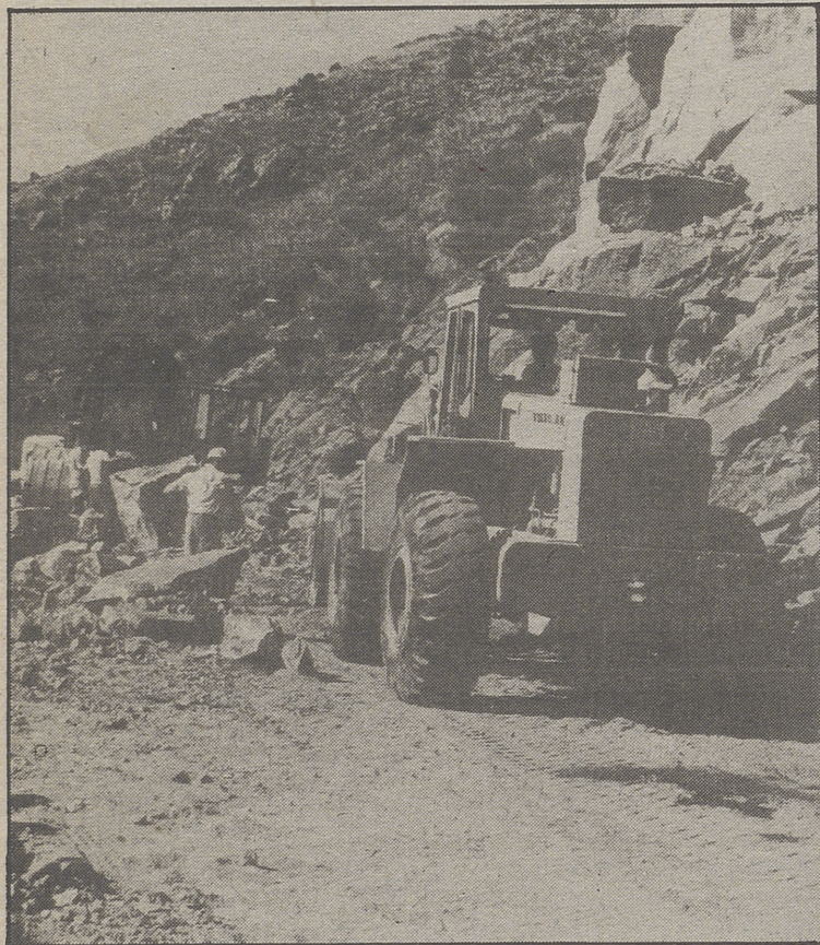
Un aspecto de las obras del Puerto del Pico
