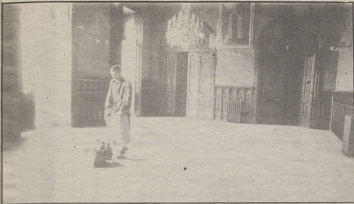
Obras en el salón de plenos
