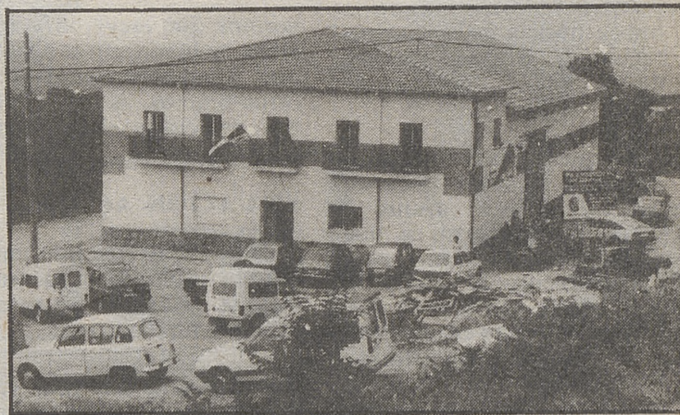
Nave de la cooperativa de Poyales del Hoyo
