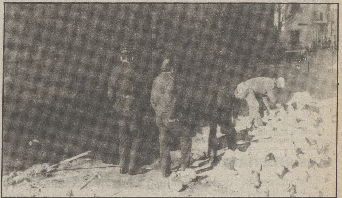
Una obra polémica, a la entrada del pueblo
