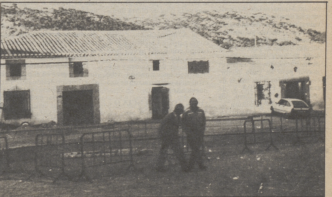
Una obra necesaria, la realizada para encontrar una fuga de agua
