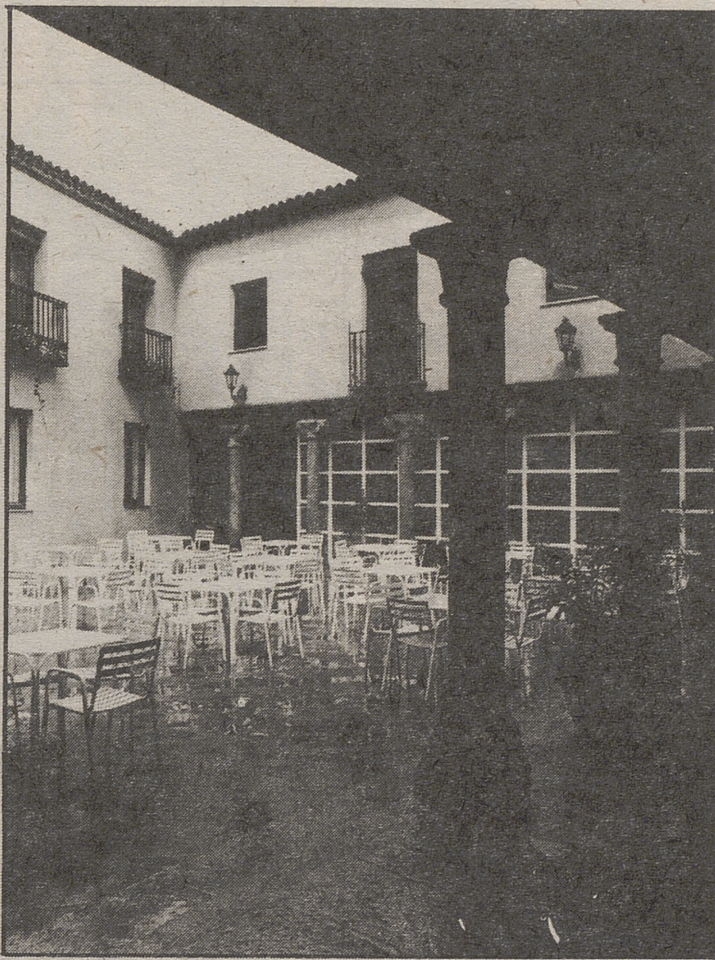
Un ejemplo de la rehabilitación de un edificio, La Posada de la Fruta.
